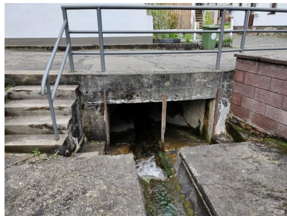
Straßenunterführung Reichelbach Dorfstraße
